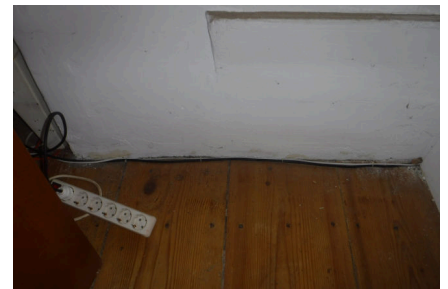
(c) Passage vers l'extérieur du placard, long du fil d'alimentation électrique de la multiprise parafoudre.
