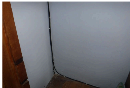
(b) Le câble de téléphone RJ11 descend le long du placard du switch en suivant le câble Ethernet de la borne de la Salle à Manger.
