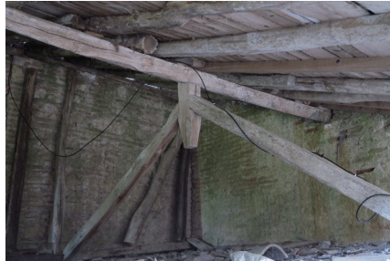
(e) Passage à l'intérieur du grenier du Préau. Une grande quantité de mou a été laissée ici en prévision de potentiels futurs travaux dans la Ruine que le câble traverse ensuite.
