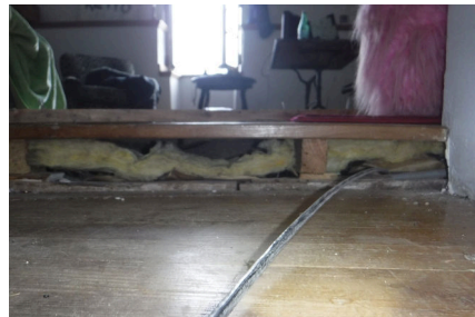
(c) Passage à l'intérieur du plancher de la chambre elle-même (éventré sur la photo).
