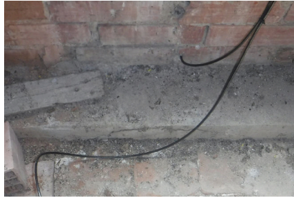
(b) Percée dans le mur extérieur (câble au-dessus).
