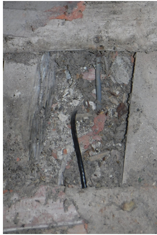
(b) Passage vers la Chambre de la Cour, en perçant dans le sol.
