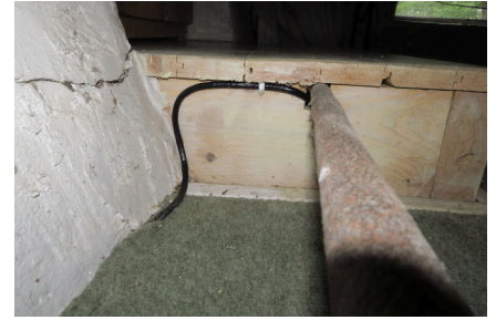
(c) Passage à l'intérieur de la marche qui mène au Petit Dortoir, après un retour au sol sous la moquette.
