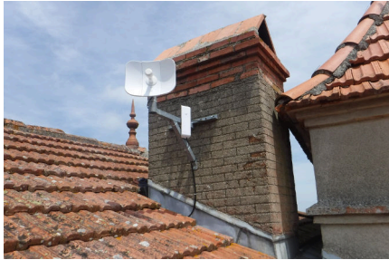
(d) La grosse antenne (directionnelle) est une LiteBeam AC qui pointe vers le Carla-Bayle. La petite rectangulaire est une NanoStation M5 (cf. Section 2.2.3 de la partie LAN pour comprendre son utilité).
