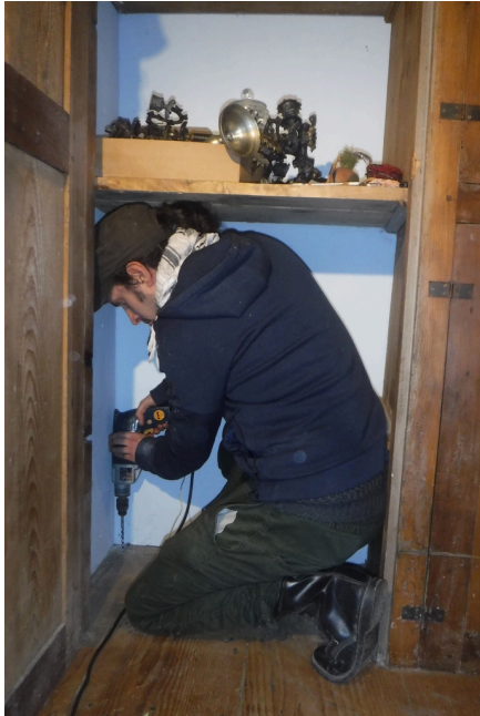
(a) Percée dans le sol du placard qui switch (au-dessus). C'est le seul câble qui ne passe pas par le grenier.
