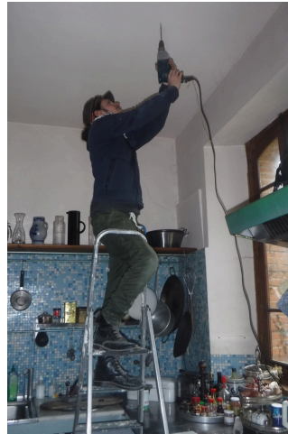
(g) Percée entre le Plafond de la Cuisine et le dessous du plancher de la Chambre de la Cour.
