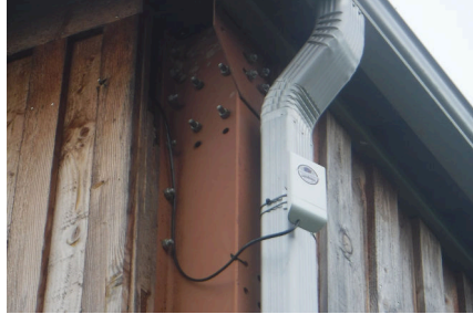
(e) Passage du câble de l'antenne vers l'intérieur du hangar, au travers les planches de bois.
