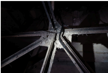
(g) Le système de poutres permet de facilement amener les câbles partout dans le grenier.
