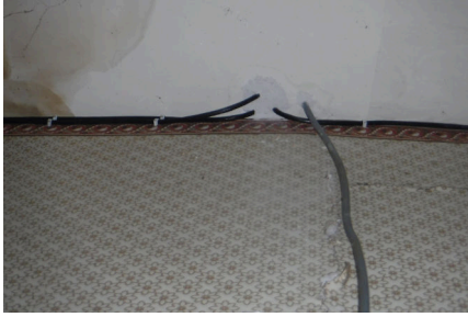
(a) Le départ du câble de la borne de la Cuisine de l'Appartement du RDC suit le même chemin que celui pour la Cuisine de l'Appartement du 1er. Il part à gauche.
