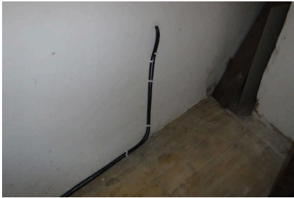
(d) Passage vers le Grand Dortoir. Passer à cet endroit du mur permet de percer une partie du mur porteur qui n'est faite que de briques.
