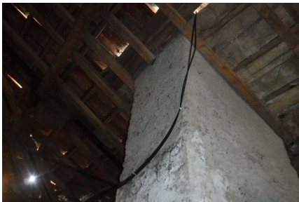
(d) À droite, 2 câbles alimentent les antennes (upstream et pont vers le cirque) sur le toit.
