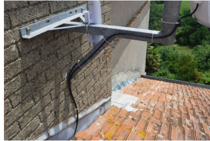
(e) Les antennes sont placées côté Sud du château, qui est la plus belle façade du lieu. Les câbles ont été au maximum camouflés derrière le mât.
