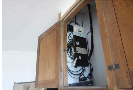
(b) 11 câbles (LAN et WAN) partent vers le plafond, et 1 seul part vers le sol (borne wifi de la Salle à Manger). Équipements de haut en bas : client VoIP en noir et routeur en blanc, switch PoE, multiprise parafoudre.
