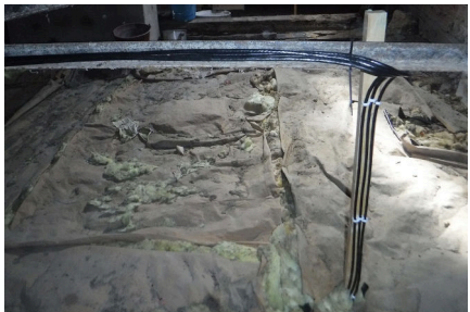
(a) Départ depuis le grenier, avec un lot de 3 câbles pour 3 bornes différentes.
