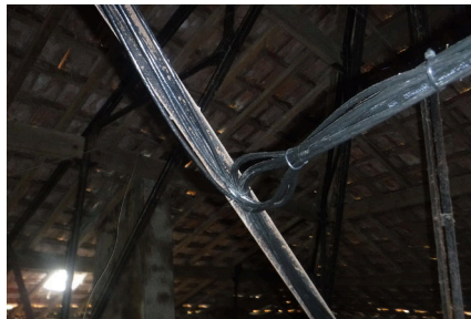
(e) À gauche, les câbles longent les poutres métalliques pour aller alimenter les bornes wifi du château. Le propriétaire ne souhaitait pas qu'il y ait de nouveaux câbles dans le sol, déjà très encombré.
