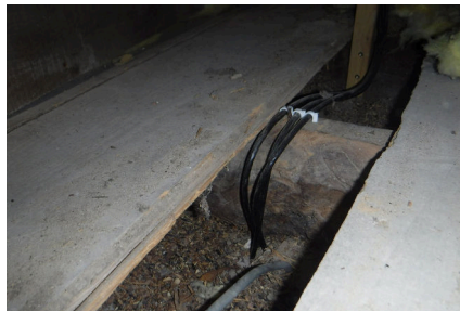
(b) Passage à l'intérieur du plancher du grenier, et percée dans le sol à proximité du câble électrique gris.
