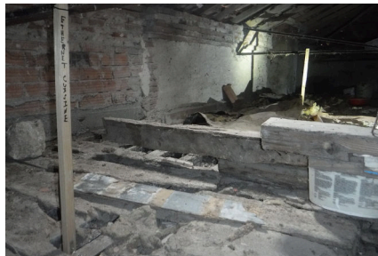
(h) Les retours au sol pour traverser les plafonds sont matérialisés par des poteaux en bois.
