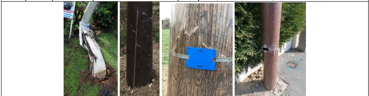
Exemples de poteau composite non utilisable : étiquette jaune, chocs, fissures, trous
