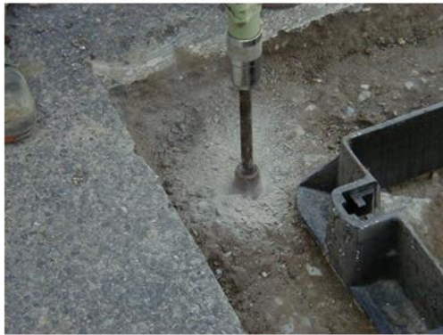
PERCEMENTS POUR FER DE REPRISE
