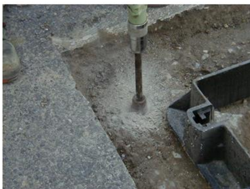
PERCEMENTS POUR FER DE REPRISE
