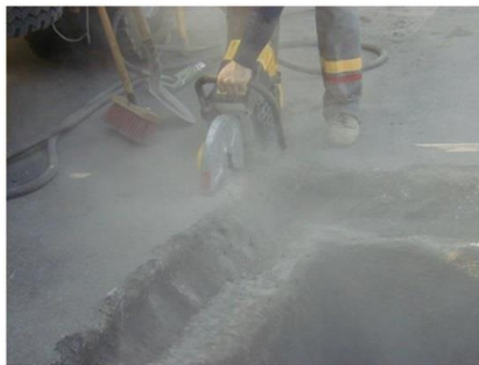
DECOUPE SOIGNEE DU REVETEMENT
