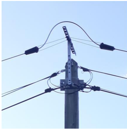
câble optique positionné en nappe haute, avec rehausse
