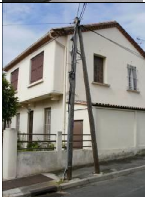
Appui couple en arrêt
