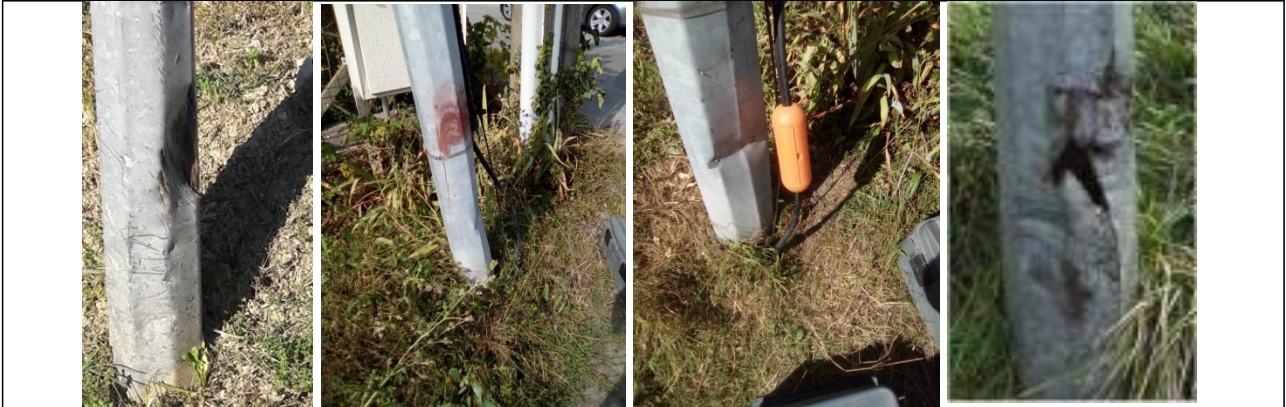
Exemples de poteau métal non utilisable : étiquette jaune, chocs d'épaveuse, trace de rouille
