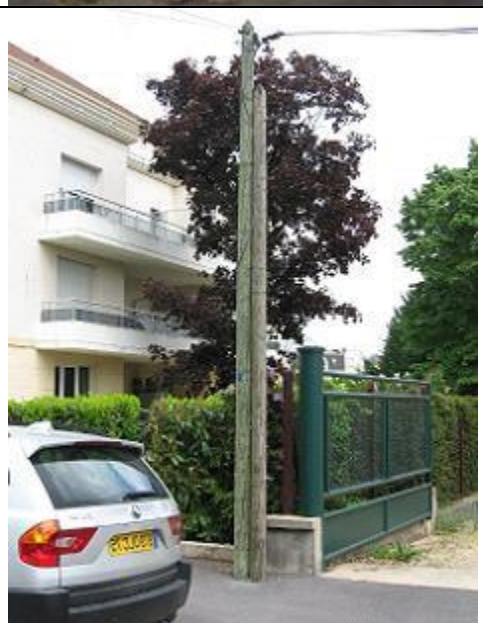
Appui moisé (ou jumelé) en arrêt
