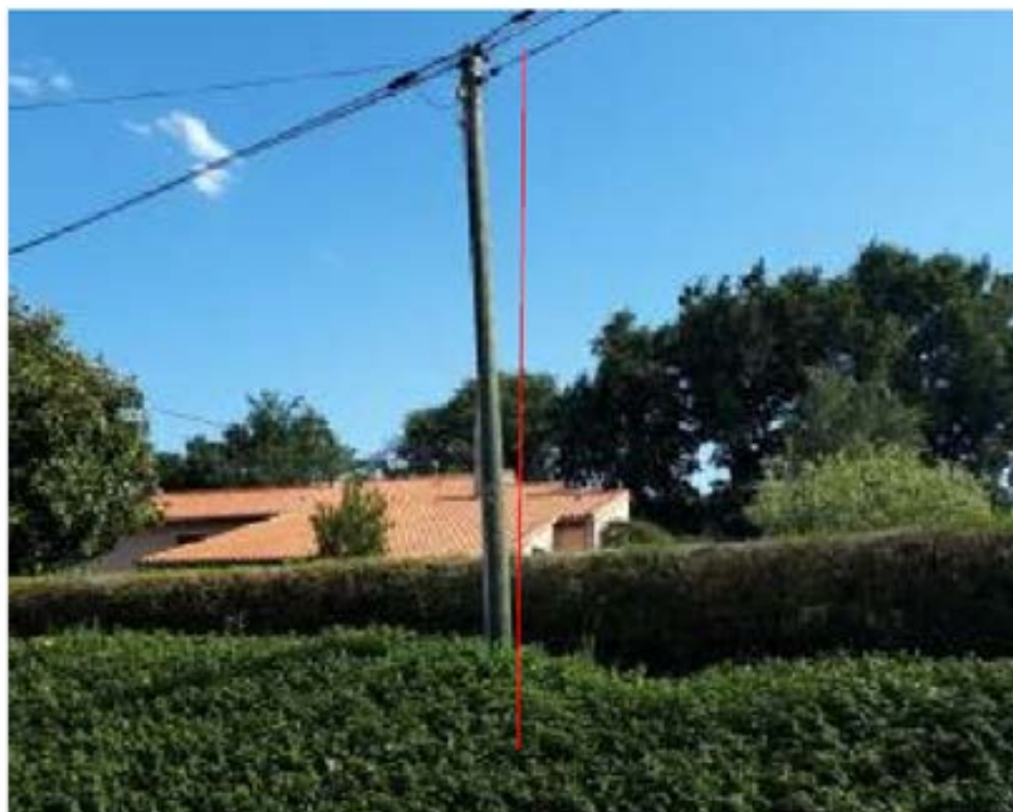
Remplacement par un 7 mètres Fibre renforcé (FR7)
