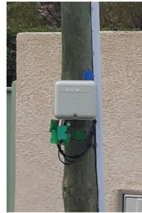
Point de branchement optique avec gaine de protection pour le cheminement du câble
