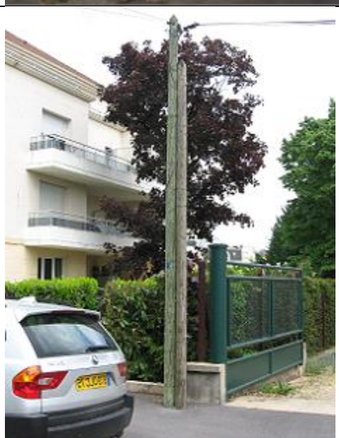
Appui moisé (ou jumelé) en arrêt
