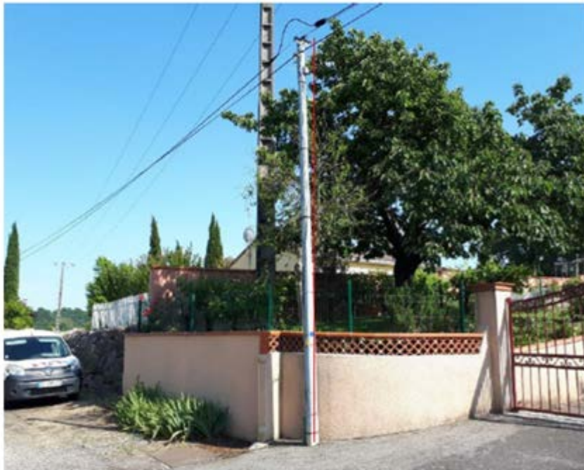
Remplacement par un 7 mètres Fibre renforcé (FR7)
