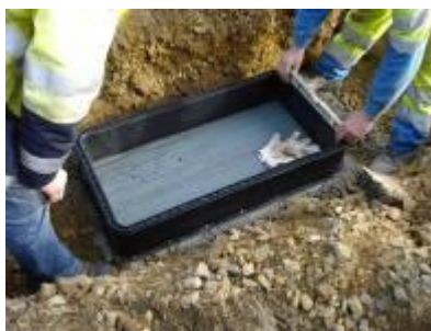
2 - Fond sur béton d'assise
