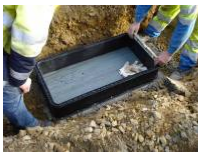
2 - Fond sur béton d'assise
