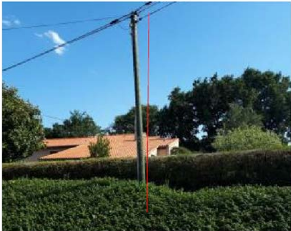
Remplacement par un 7 mètres Fibre renforcé (FR7)
