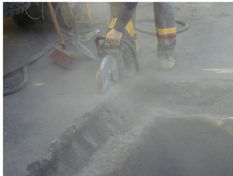
DECOUPE SOIGNEE DU REVETEMENT
