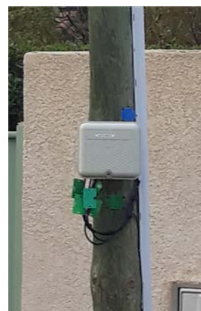
Point de branchement optique avec gaine de protection pour le cheminement du câble
