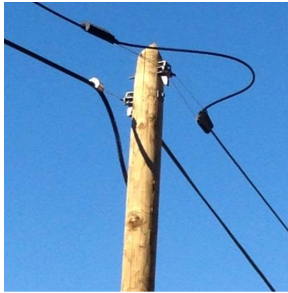
câble optique positionné en nappe standard, sans rehausse
