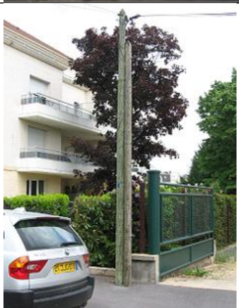
Appui moisé (ou jumelé) en arrêt
