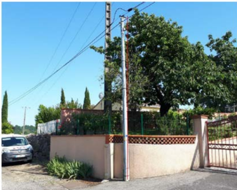
Remplacement par un 7 mètres Fibre renforcé (FR7)
