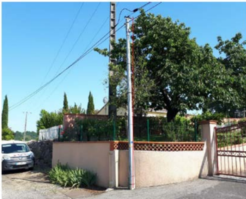
Remplacement par un 7 mètres Fibre renforcé (FR7)
