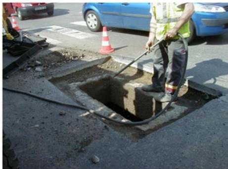
NETTOYAGE DU SUPPORT A L'AIR
