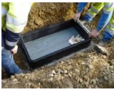
2 - Fond sur béton d'assise
