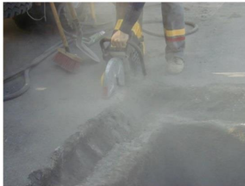
DECOUPE SOIGNEE DU REVETEMENT
