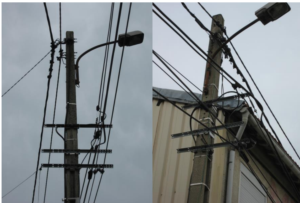
(4) Point d'appui mixte ERDF/Eclairage public
