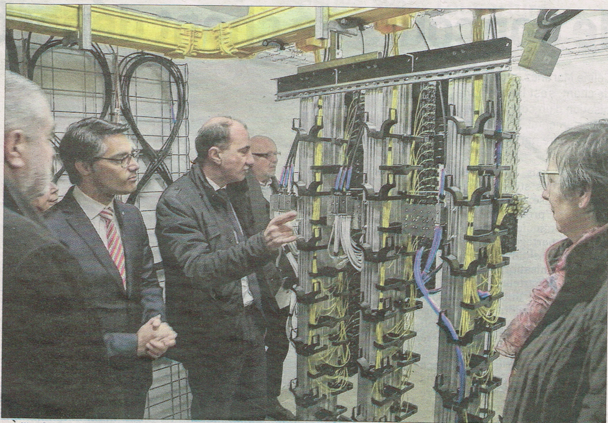
■ À l'intérieur du nœud de raccordement optique d'où partent les fibres optiques qui alimentent l'ensemble de la ville. Photo Christian GIZON
