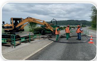
► **Valsenhône** : Réfection des joints après le rebouchage d'une tranchée.
