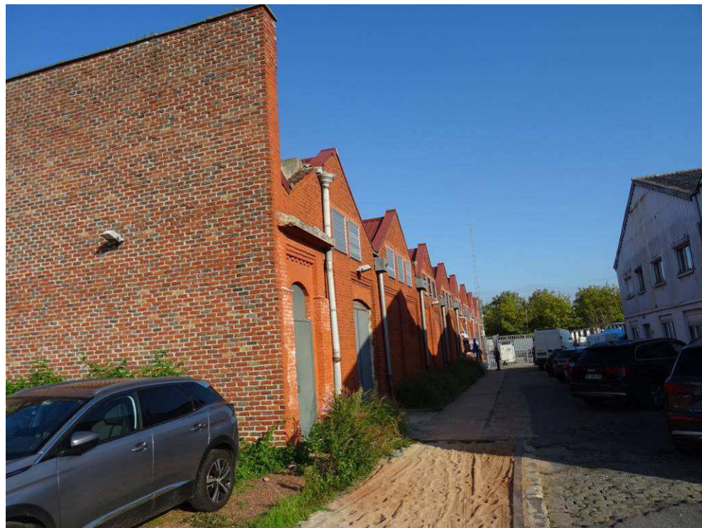
Vue de la structure
