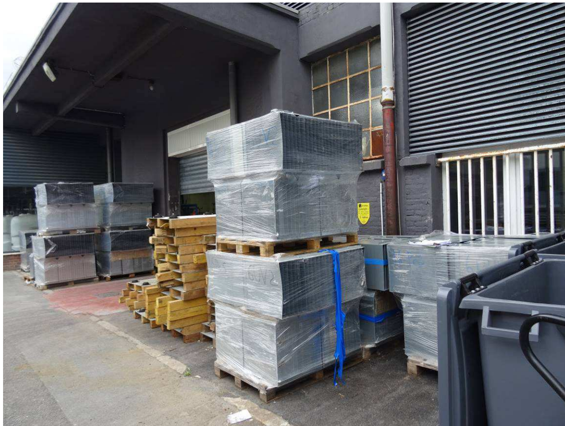
Le compteur de coups de foudre présent affiche 0 La gouttière métallique n'est pas reliée à la descente
