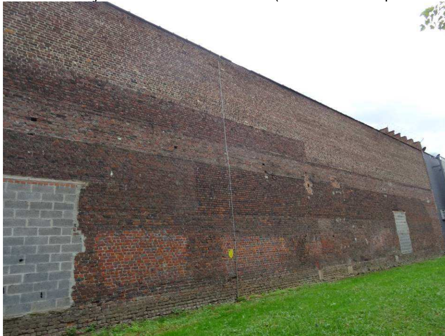
Vue d'une façade côté rue Kellermann (1 descente est présente)
