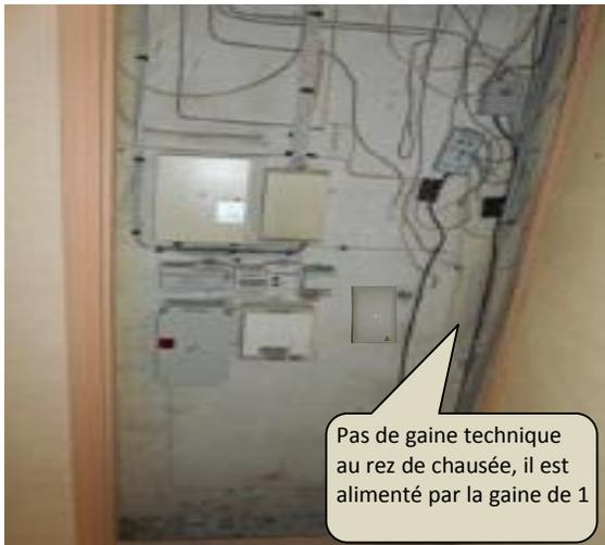
Pas de gaine technique au rez de chaussée, il est alimenté par la gaine de 1
