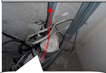
SORTIE DE PIED DE COLONNE
