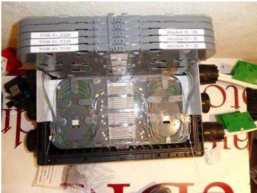
Figure 31 : boîte d'épissage en pied de colonne montante
