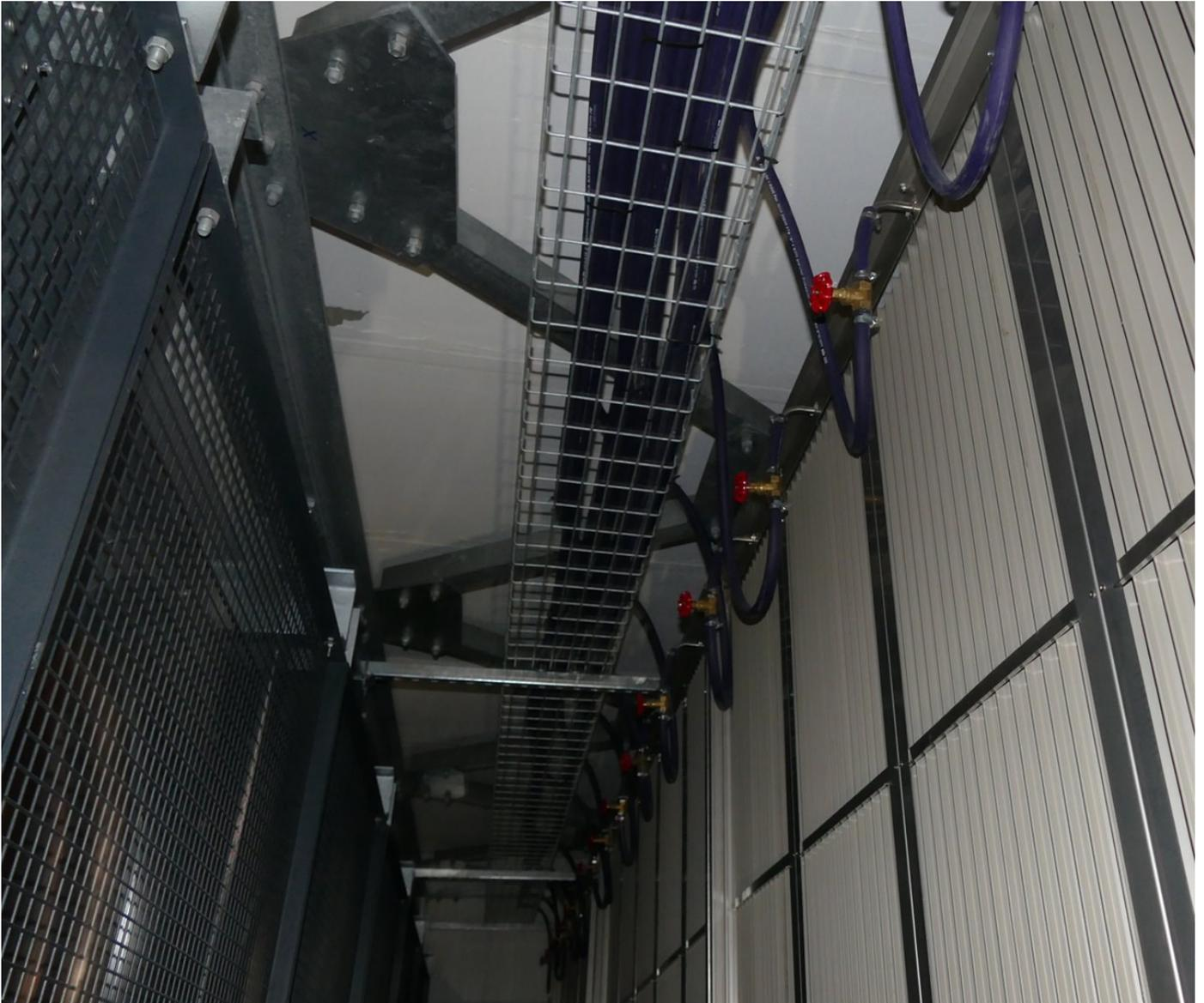
Le débit de l'eau est réglé très finement : toute l'eau osmosée doit s'être évaporée quand le système est bien réglé. Voici les 5 vannes d'eau osmosée qui permettent de contrôler précisément le volume d'eau (au litre près) injecté de façon uniforme sur les médias adiabatiques :
