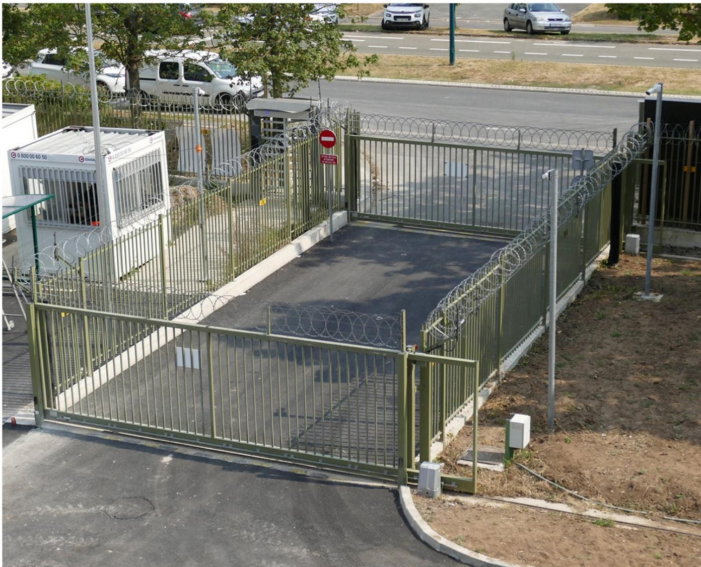
La clôture est électrifiée avec 3 câbles qui délivrent une tension de plus de 10 000 volts, mais avec une faible intensité, afin de ne pas mettre la vie en danger.
