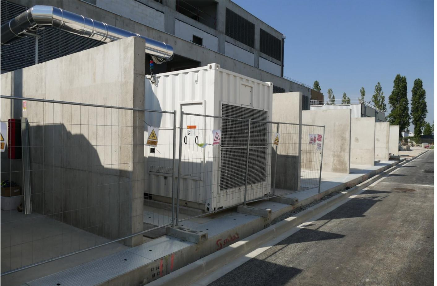
Ce sont des groupes électrogènes basse tension (400 volts). Ce sont les mêmes que ceux de DC3 que Scaleway exploite depuis plusieurs années et qui ont passés la certification tier3 de l'uptime institute qui exige des groupes électrogènes de production (et non de secours) capables de fonctionner sans interruption de service à pleine charge et sans limitation de durée.
