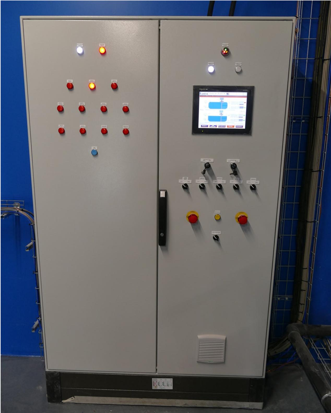
L'automate permet de définir les seuils d'alertes (trop pleins, alarme niveau bas), mais aussi le seuil où l'automate déclenche l'osmoseur pour remplir la cuve et celui où il arrête l'osmoseur.
