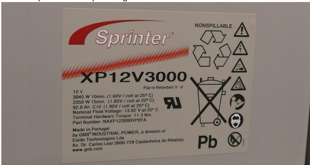
Quelle autonomie permettent ces batteries ? Au strict minimum 6 minutes. Cette durée est calculée dans le cas le plus défavorable : Pleine puissance (6 kW / baie de moyenne) et batteries en fin de vie, c'est-à-dire au bout de 10 ans.
