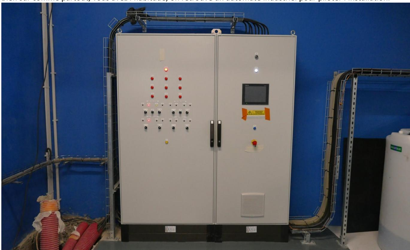
C'est lui qui pilote l'accumulateur, les groupes froids, les vannes motorisées et les pompes :
