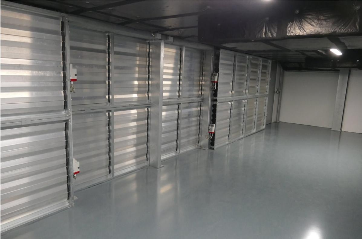
Quand on est en mode mélange, les volets s'ouvrent partiellement et l'air chaud de reprise se mélange à l'air frais extérieur pour être ensuite diffusé par le haut en salles serveurs.
