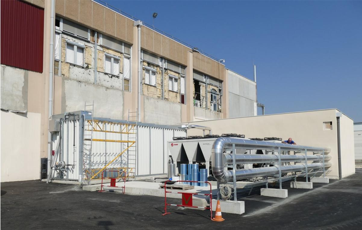
Un emplacement pour un 3ème groupe frigorifique est prévu ainsi que des attentes pour raccordement d'un groupe frigorifique mobile en cas de nécessité :
