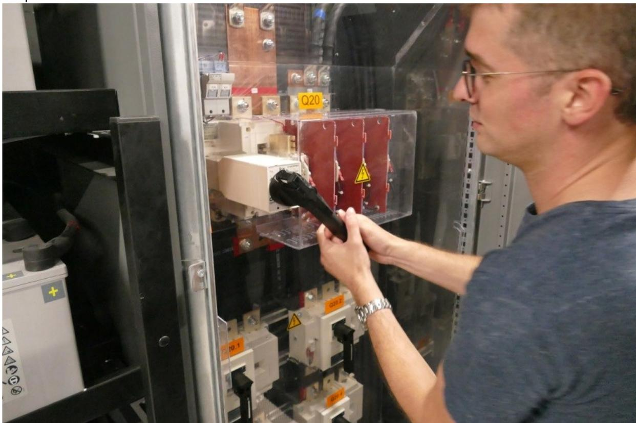
Savez-vous ce que c'est ? Ce sont 4 fusibles de 650 ampères, pour les 4 branches de batteries. Le câble permet de monitorer si le fusible a fondu et le circuit est ouvert.
