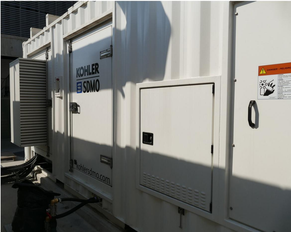
Ces groupes électrogènes sont préchauffés et reprennent la charge en 12 secondes. Les batteries onduleurs permettent de tenir à pleine charge 6 minutes fin de vie, c'est-à-dire au bout de 10 ans.
