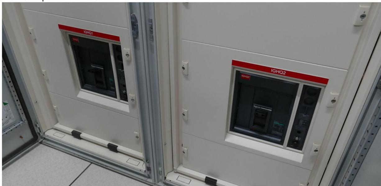
C'est un interrupteur et non un disjoncteur : il ne coupe pas le courant en cas de dépassement de l'intensité. Cette fonction est déjà réalisée à un autre endroit sur le circuit.
