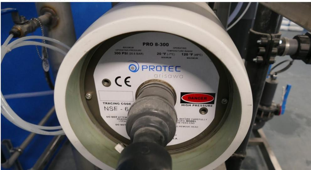
Toutes les deux à quatre minutes, les membranes d'osmose inverse sont rincées : le principe consiste à faire circuler de l'eau dans l'autre sens pour rejeter les impuretés coincées dans la membrane.
