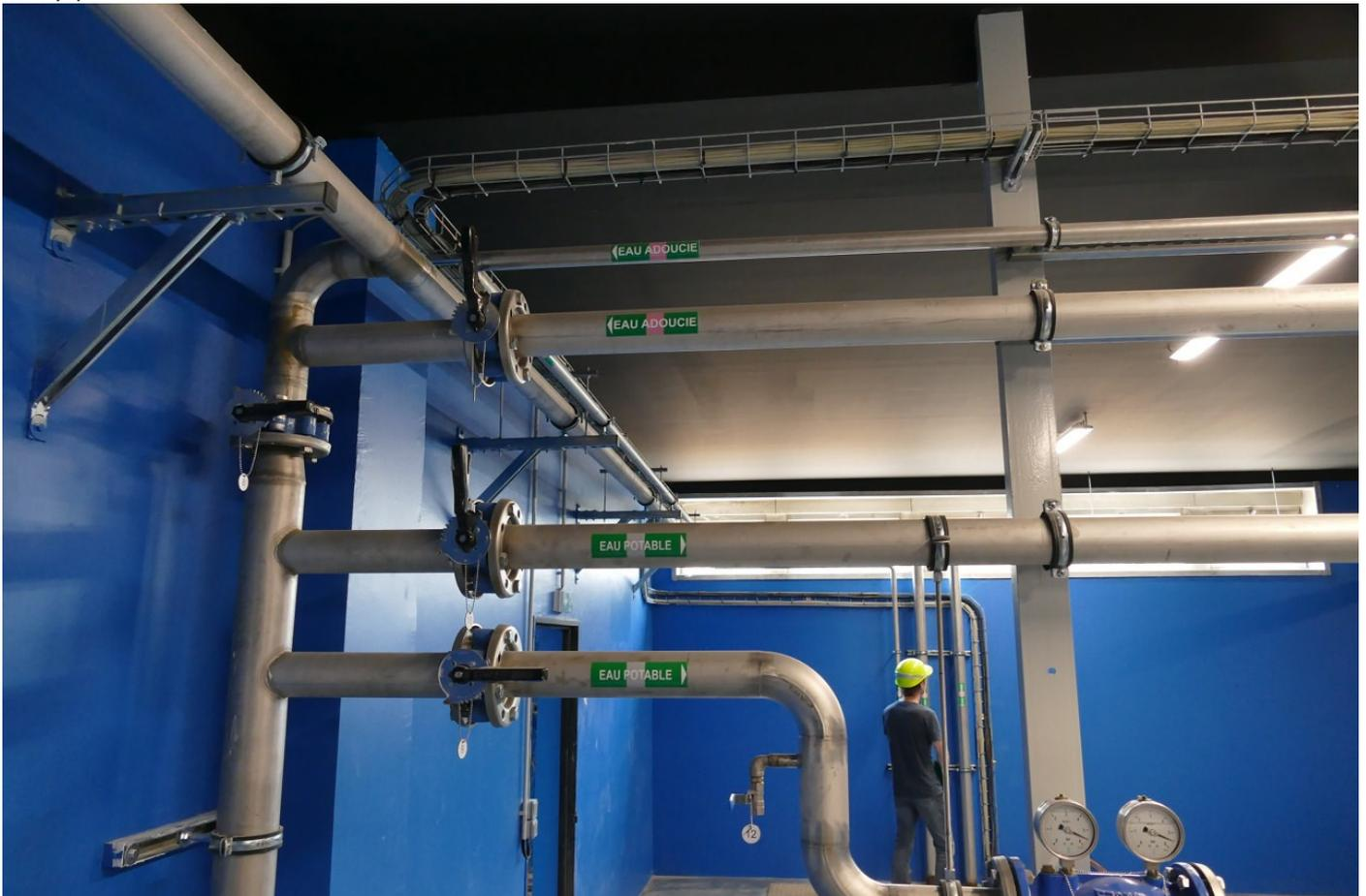
La consommation d'eau osmosée maximum est de 25 m<sup>3</sup>/h pour le data center quand les 12 salles serveurs seront en service. Cela permet le refroidissement de l'air de 10 degrés C. pour près de 22 MW de serveurs.
