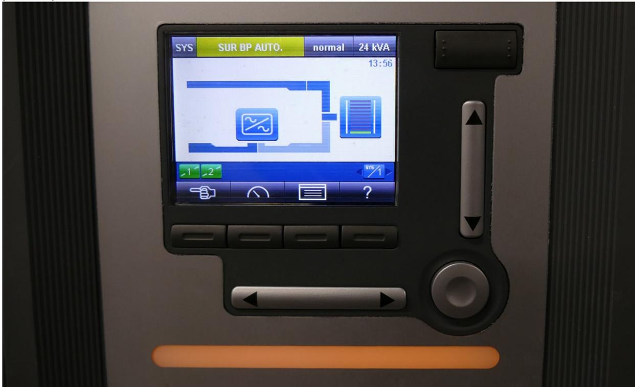
Ci-dessous, nous avons une coupure de courant simulée et le data center fonctionne sur groupe électrogène. L'onduleur force le mode double conversion par mesure de sécurité. Dans ce mode, le rendement est de 94 % Tandis qu'en « Éco mode » le rendement est proche de 99,9 % à pleine charge.
