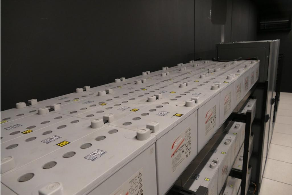
Les batteries utilisées : Ce sont des batteries au plomb étanche AGM SPRINTER XP12V3000 (350€ l'unité). D'une tension de 12 volts, elles ont chacune une capacité de 92.8Ah à 25°C.
