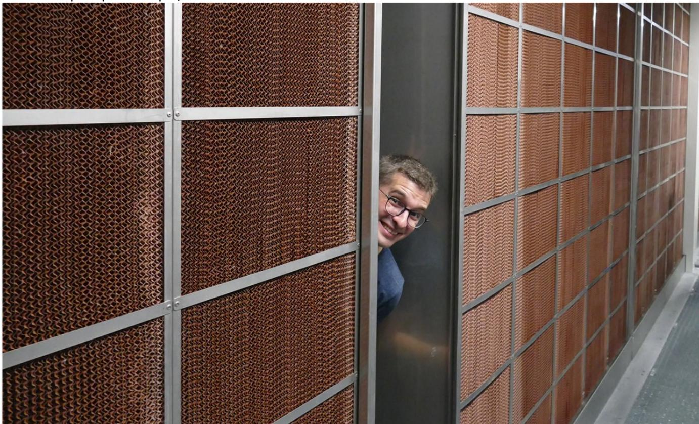
Le mélange d'air recyclé et d'air neuf arrive par les grilles situées sous nos pieds. Il y a également quelques filtres qui apportent l'air neuf, la matrice de filtrage d'air neuf fait plus d'un étage de haut, cumulant ainsi pas moins de 40m2 de filtration.
