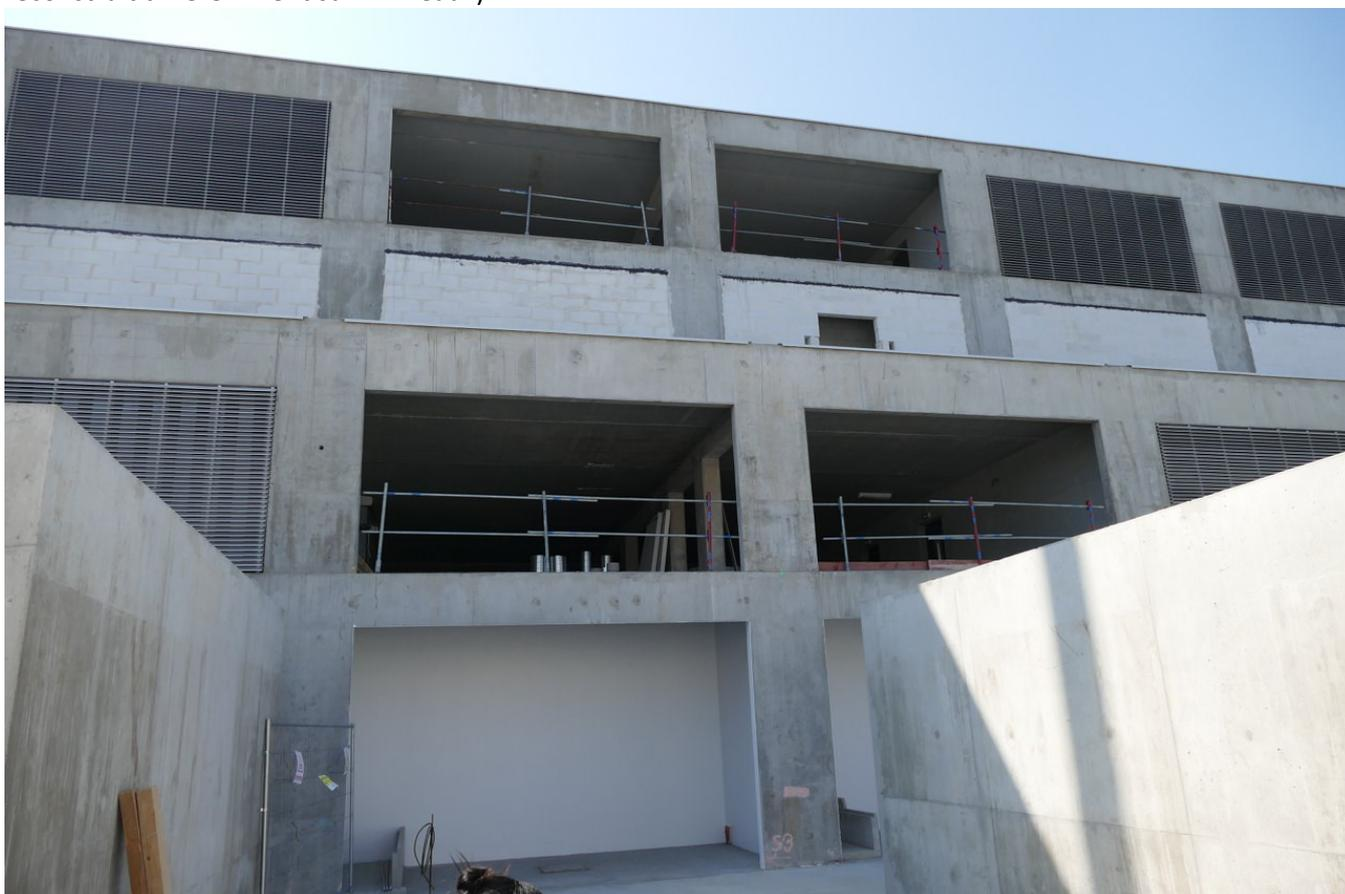
Comme pour l'entrée d'air, Scaleway a mis des pièges à son, visibles sur cette photo (oups ! Une vantelle à remplacer visiblement) :
