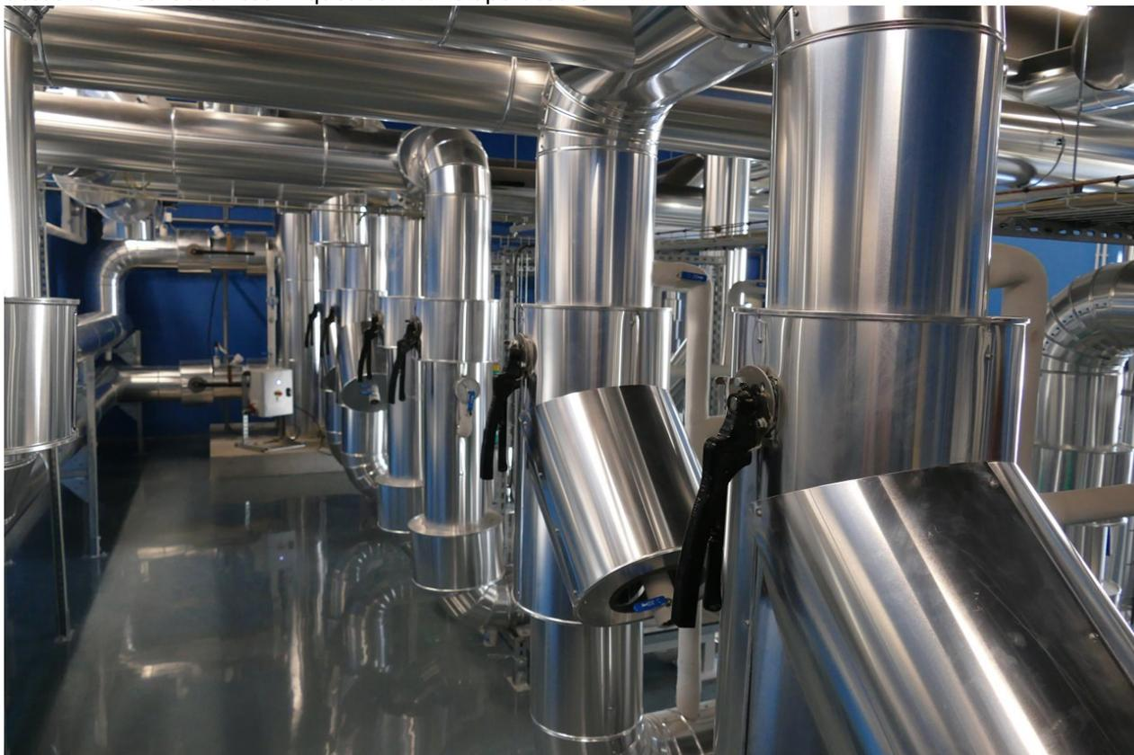
Chaque circuit a deux pompes : une active et une en secours. Voici les pompes du circuit primaire :
