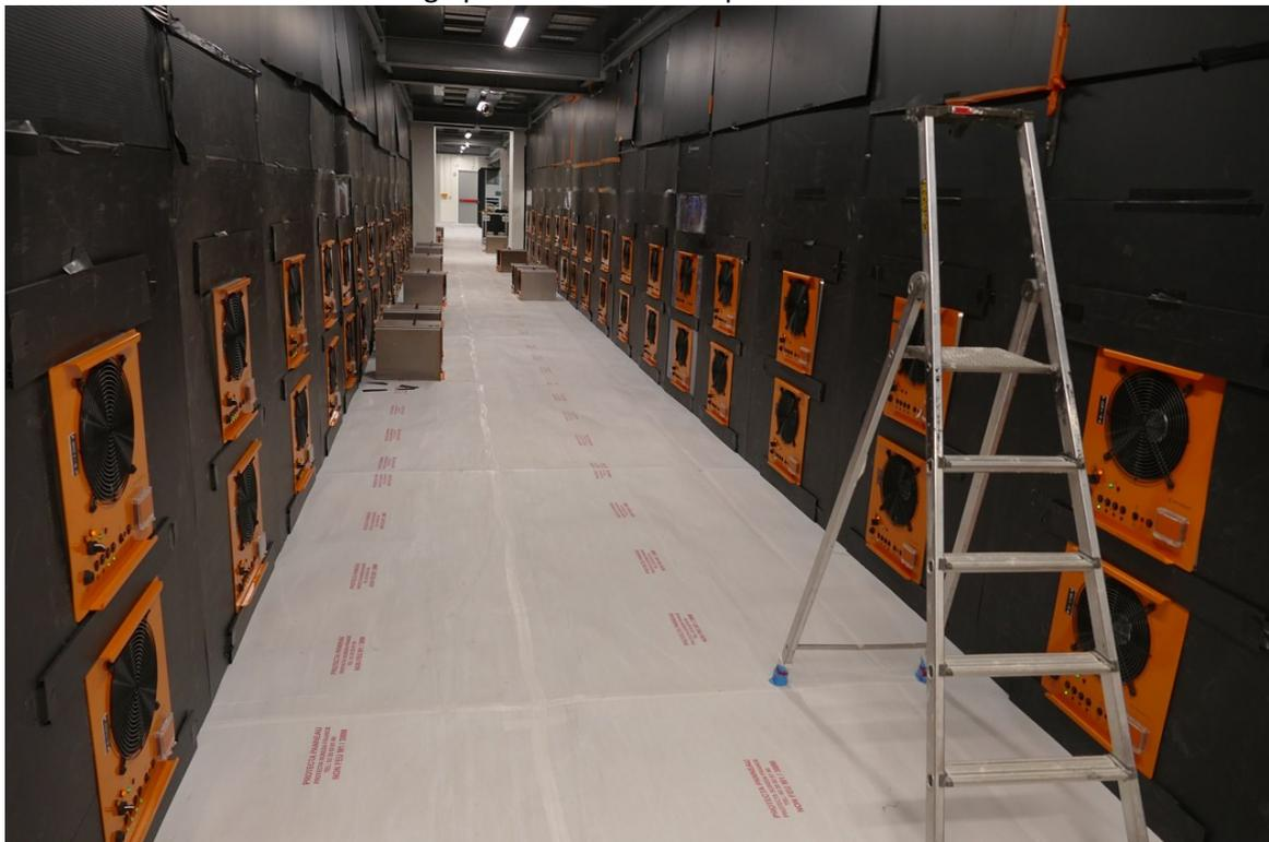
À quoi ressemble un élément de charge ? A un gros radiateur soufflant utilisé pour chauffer des entrepôts, mais c'est vraiment un outil de charge, avec double alimentation en contrôle de la charge par PC, variable de 0,5kW en 0,5kW (7 kW maximum par unité).
