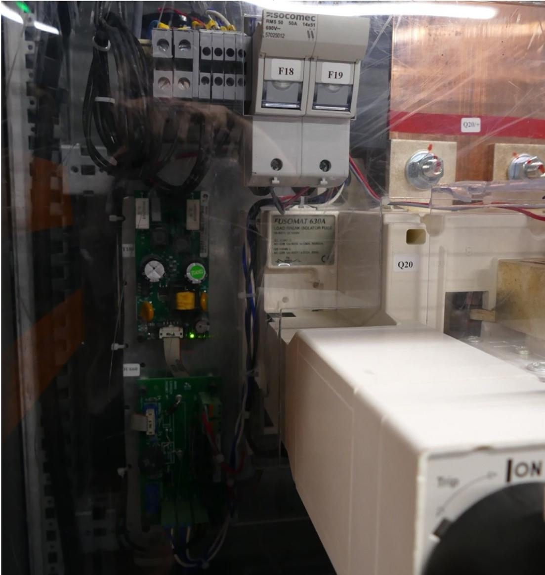
Cette électronique permet de collecter les données des différentes sondes de température qui sont placées à proximités des batteries. La température est un paramètre utilisé pour optimiser le courant de floating et optimiser le temps de recharge.
