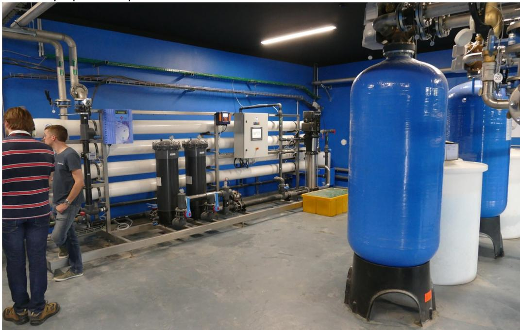
La saumure (eau et sodium) sert à régénérer la résine échangeuse d'ions dans un adoucisseur.
