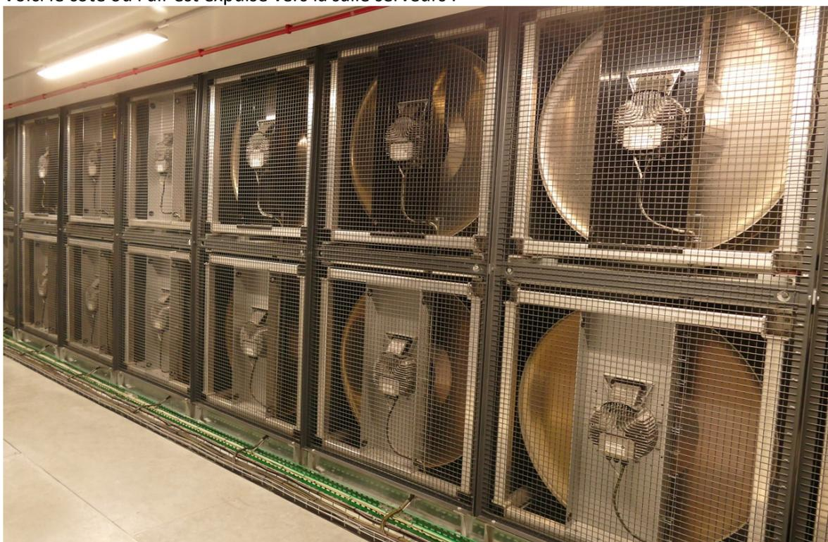
On a bien sur testé la mise hors-tension d'un ventilateur pour voir la réaction de l'automate : immédiatement les autres ventilateurs accélèrent pour compenser sa perte.
