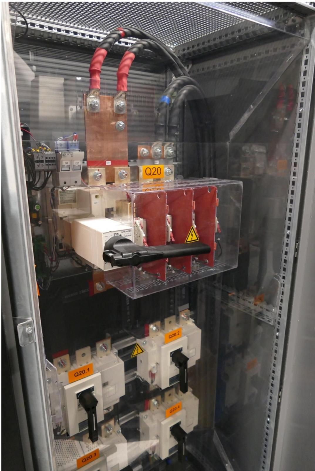
Ici on voit Arnaud en train de simuler une panne de l'ensemble des batteries : Quand la photo a été prise le data center a une coupure de courant simulée et fonctionne sur groupe électrogène. Cela permet de vérifier la réaction de l'automate qui doit sortir du mode Online et basculer la charge directement sur le groupe électrogène, sans coupure.
