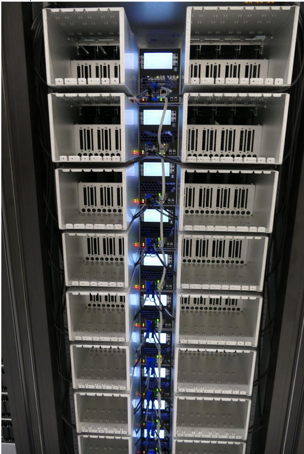
Physiquement, là où Dell met 4 serveurs dans un châssis de 2u, Scaleway place 7 serveurs dans un châssis de 3u: 3 à gauche et 4 à droite. Par défaut, ces serveurs n'ont pas de disques en local et démarrent sur un disque réseau.
