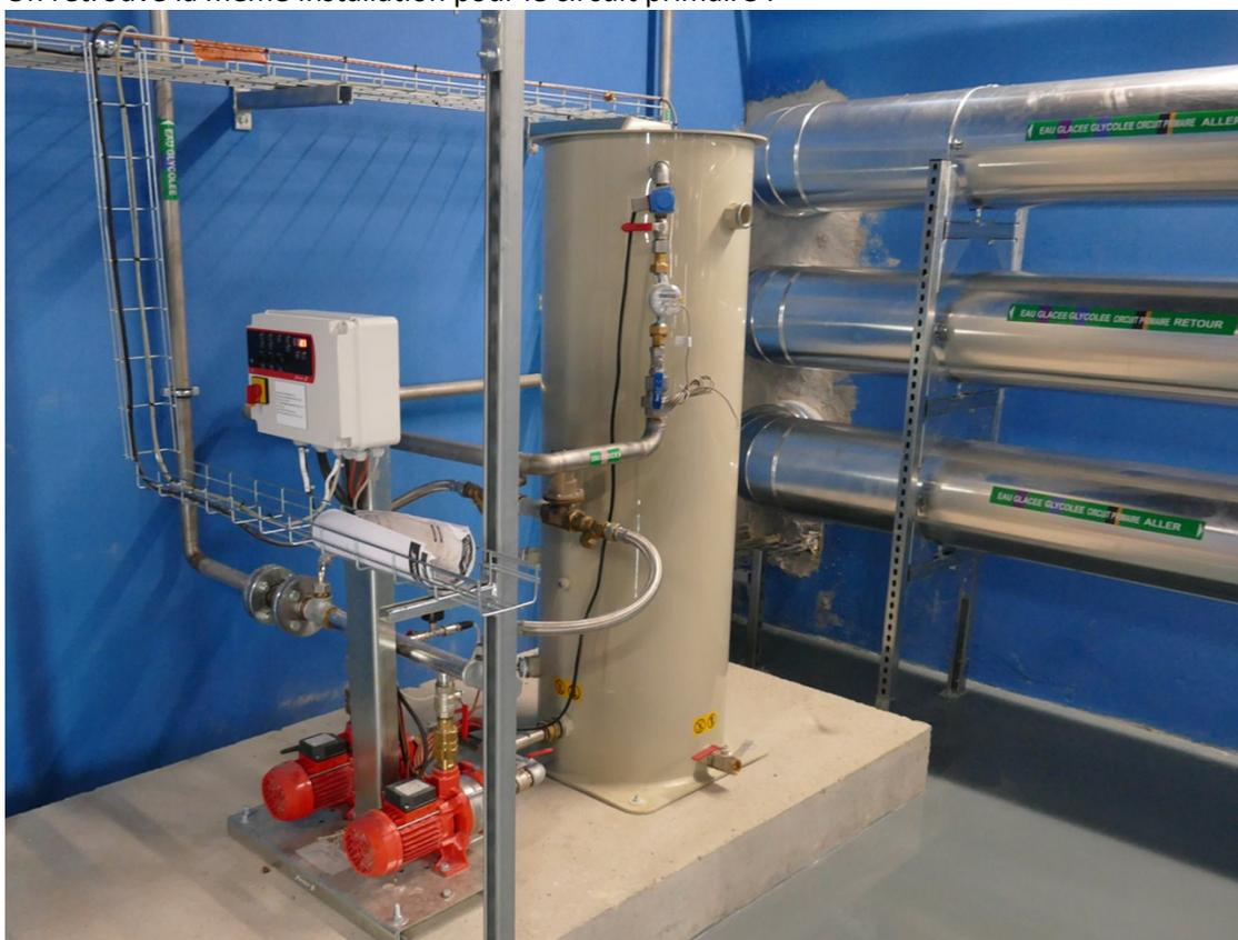
À côté se trouve la réserve d'eau glycolée et la pompe d'injection ayant servi au remplissage des réseaux. Une eau glycolée est une eau du réseau de la ville à laquelle on a ajouté un pourcentage d'antigel (par exemple 30 % de glycol) afin que cette eau ne puisse geler. Ici l'eau de ville a été traitée et adoucie préalablement. Cela n'a rien à voir avec l'eau osmosée utilisée pour le refroidissement adiabatique uniquement.
