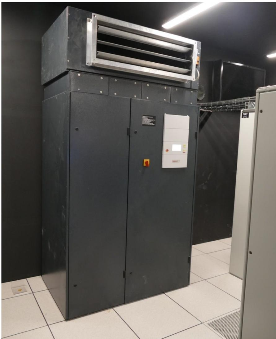
Ici, il fait plus de 25°C extérieur : les registres motorisés de la reprise d'air chaud sont ouverts pour recycler l'air et le refroidir via le circuit d'eau glacée, l'air chaud du TGBT étant plus frais que l'air extérieur :
