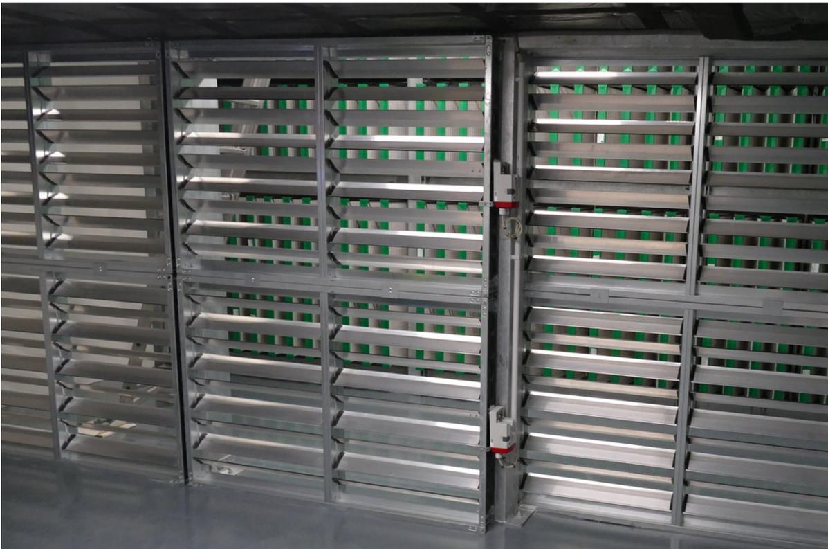
Voici l'un des 53 moteurs capable de contrôler très précisément l'ouverture des registres d'air. La défaillance de l'un d'entre eux n'a aucune incidence, le système étant prévu pour compenser la perte et garder un débit d'air identique avec une température qui respecte l'ordre donné.
