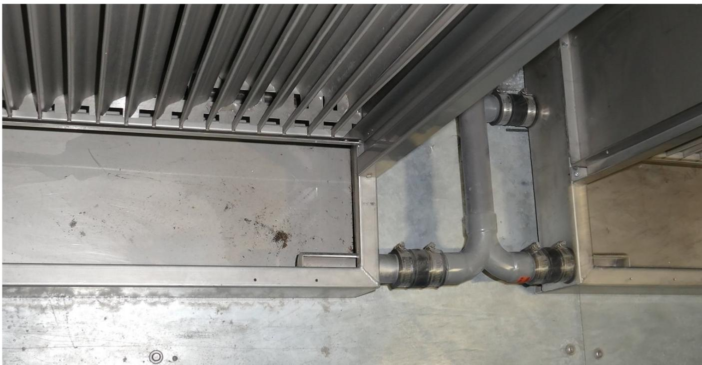
Quand le refroidissement adiabatique n'est plus utilisé, l'intégrité des circuits d'eau osmosée sont vidangés automatiquement (et mis à l'égout). Objectif : mettre l'installation hors gel et ne pas avoir d'eau stagnante dans des tuyaux, pour éviter tout risque de développement bactériologique, bien qu'avec ce système aucune particule d'eau n'est dispersée dans l'air, il n'y a donc pas de phénomène aérosol.
