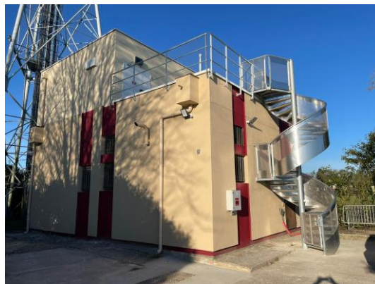
Datacenter de proximité construit au -dessus d'un bâtiment existant.
