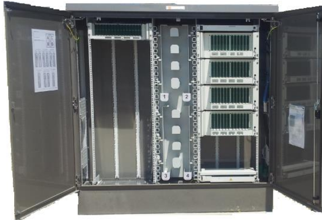
PM de capacité 576 fibres distribuées (360 locaux desservis)
