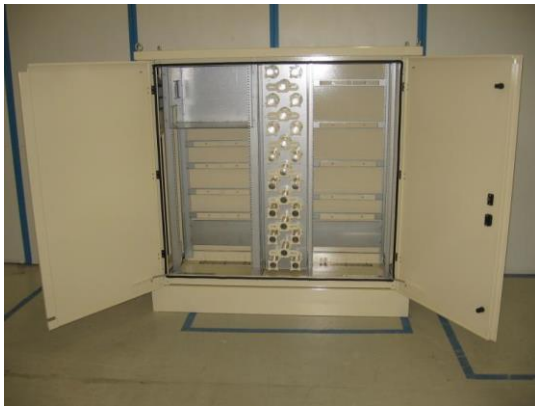
Armoire passive avec caisson interne actif
