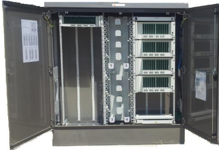
PM de capacité 576 fibres distribuées (360 locaux desservis)
