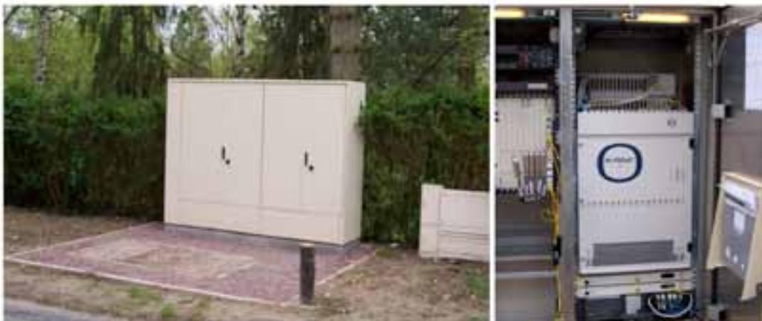
*Photo d'une armoire de montée en débit (avec DSLAM opérateur)*
