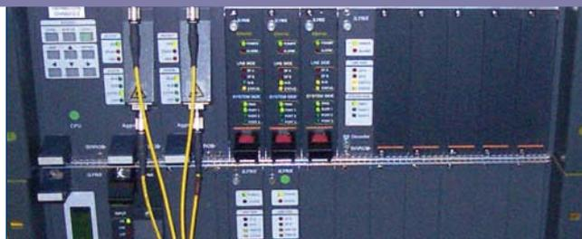
Matériel d'activation de réseau fibre optique type STM
