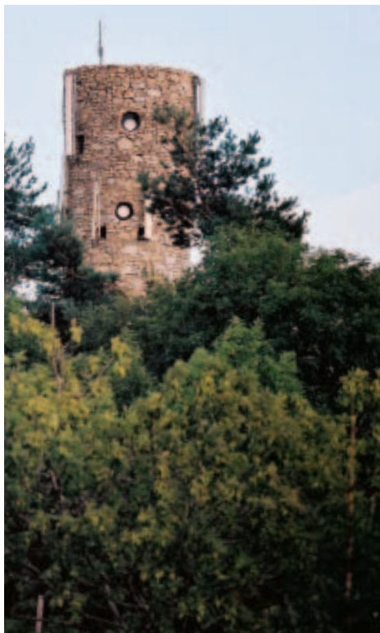
Minimiser l'impact visuel des antennes.
