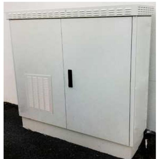
A l'intérieur seront terminées l'intégralité des fibres des câbles de distribution de la zone arrière (4x 144fo). Des emplacements sont prévus (tiroirs en châssis 19") pour pouvoir installer des coupleurs (OC en technologie PON).
