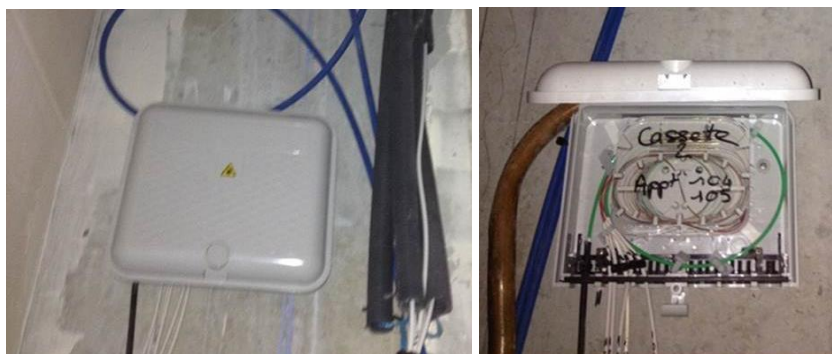
Figure 10 : PB 3M 2 cassettes de 12 soudures possibles
