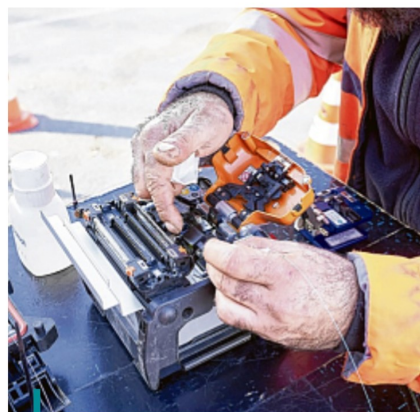
Ici, une opération de raccordement de fibre optique. Elle réclame minutie et dextérité car la fibre est un cheveu fragile.
